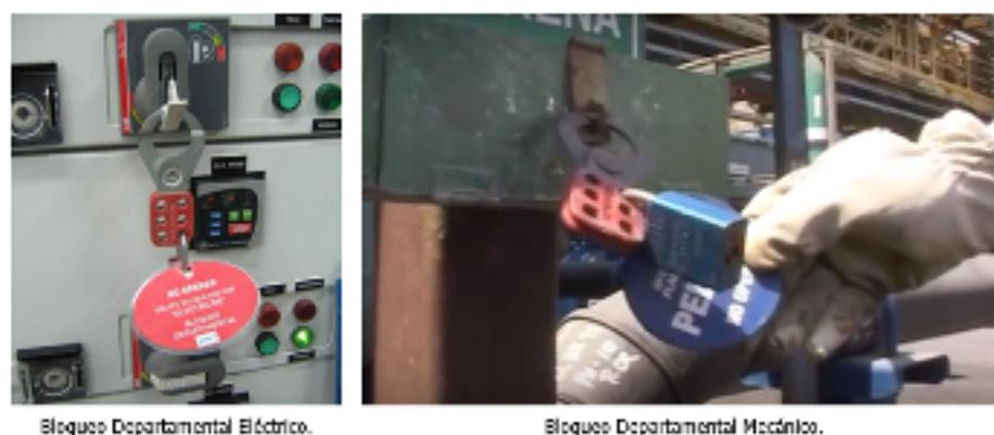
La tarjeta de bloqueo departamental es un medio visual de identificación y señalización que tienen como propósito advertir el bloqueo o la inmovilización de un equipo, instalación o sistema. Deberá estar siempre colocada junto a la pinza y candado, en los puntos de bloqueo de la fuente de energía en un lugar visible, de tal manera, que se advierta claramente.
